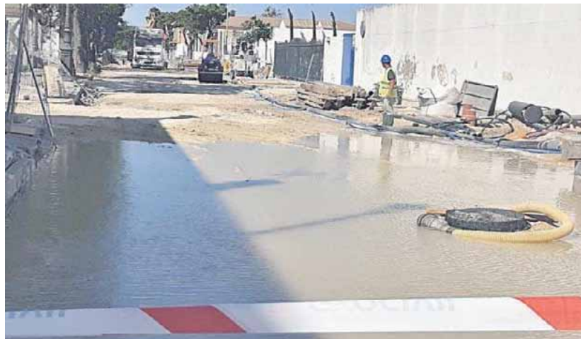
Una imagen reciente de la obra del tanque de tormentas.
