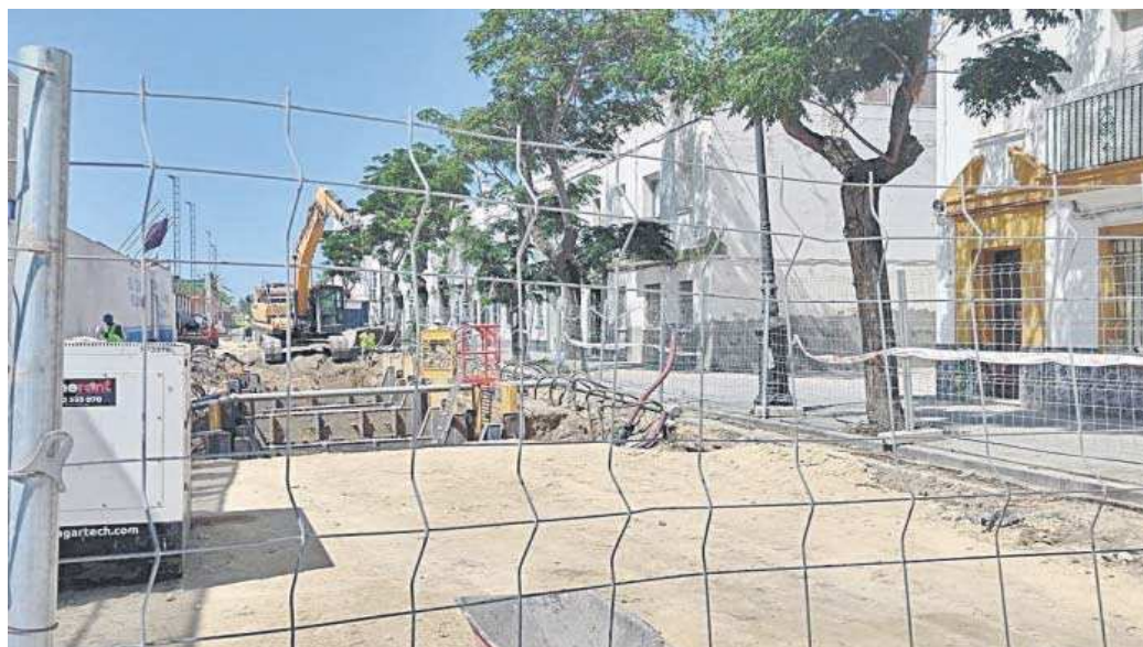
Una imagen reciente de las obras en la avenida de la Bajamar.
