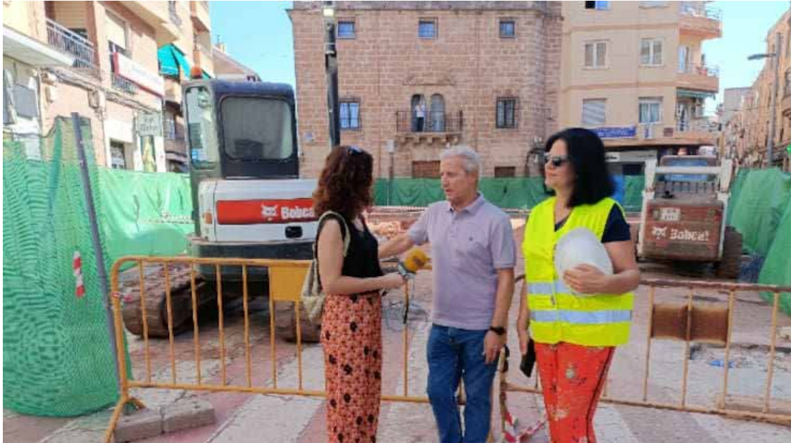
Obras hidráulicas plaza Ramón y Cajal de Linares.
