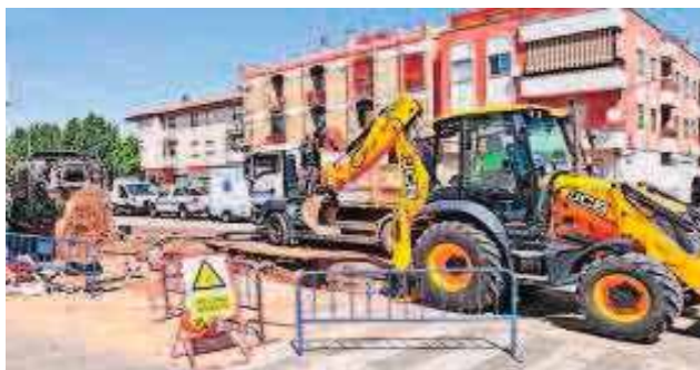
Obras de reparación del reventón registrado en la avenida de Lasalle. OBES
