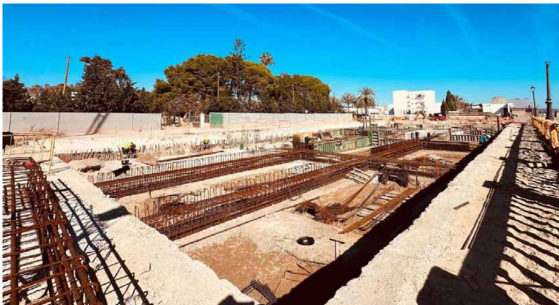
El tanque anticontaminación junto al río Guadalete.
